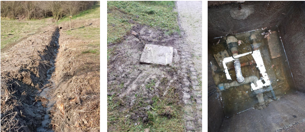
Intervento B.c.2: foto delle lavorazioni sull'impianto idrico
