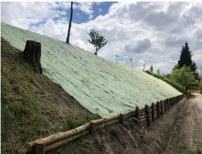
Intervento B.a.1.12: lavorazione completata con palizzata, ripristino scolo e biostuoia pre-seminata
