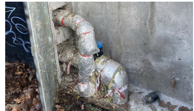
MANUFATTI ESISTENTI (parcheggio di via di Monte Albano)
