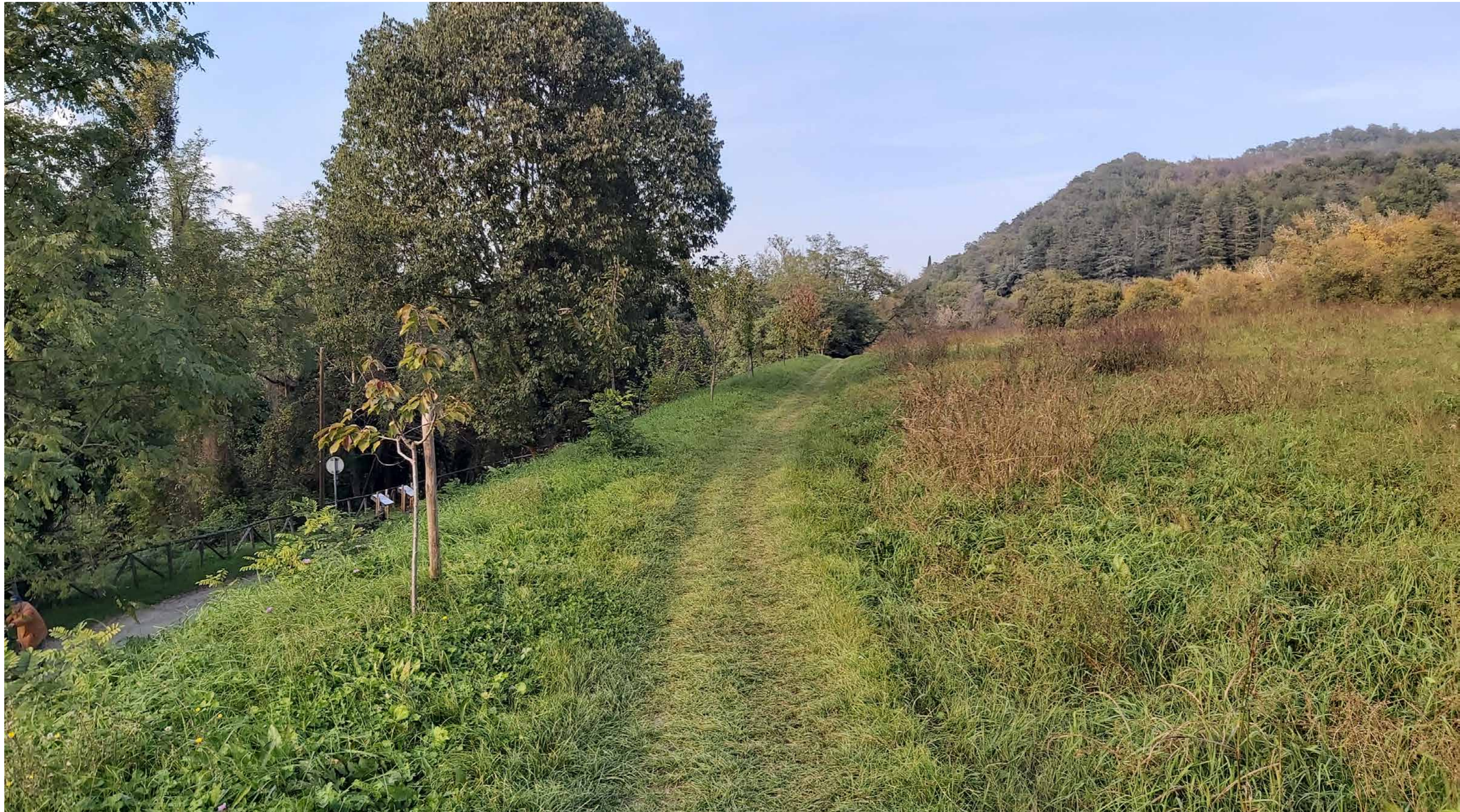
PARTE SOMMITALE DELLA SCARPATA IN CORRISPONDENZA DELLA FRANA 1
